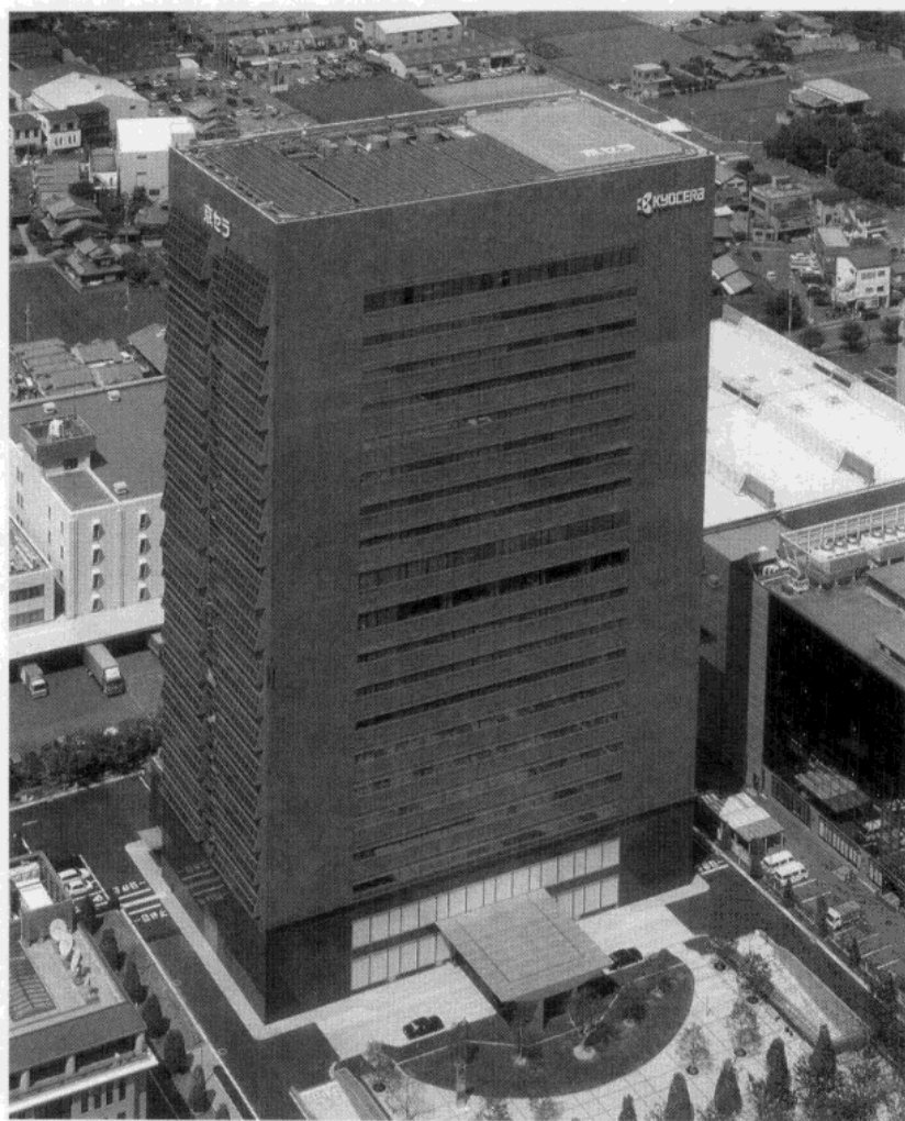
京瓷总公司办公大楼(正面图)
