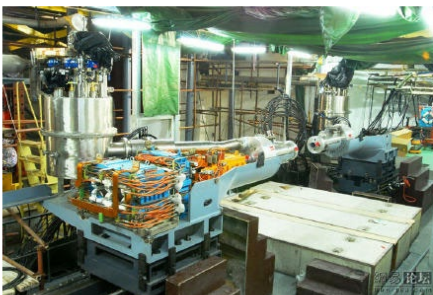
漂移室电子学和气体系统安装完成，准备做宇宙线实验
